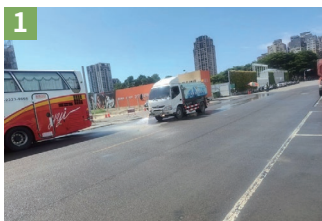
1 土方開挖運輸過程水車灑水路面避免粉塵飛揚
