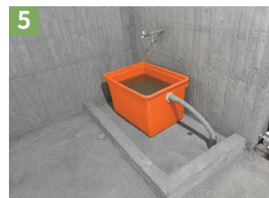
5 各層設置沉沙桶，廢水經初步沉澱後，排至廢水管
