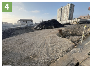
4 車輛行進動線鋪碎石級配
