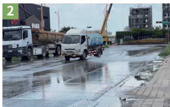
1 土方開挖運輸過程水車灑水路面避免粉塵飛揚
