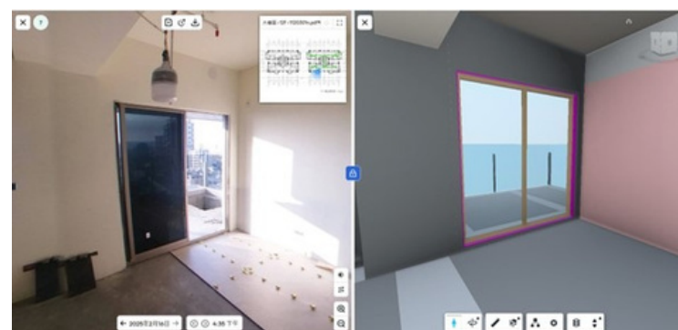
BIM模型能與現場施作過程及結果進行比較，確認現場是否依照檢討規劃結論施作。
