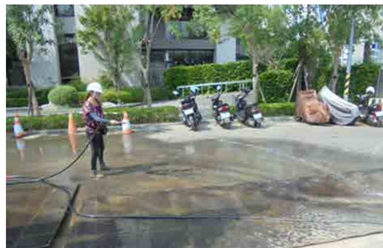
• 土方出車使用高壓清洗機清洗輪胎及車體、車輛離開後再以人工進行路面清洗
