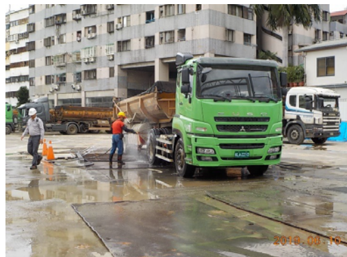
洗車台，出車使用高壓清洗機清洗輪胎及車體
