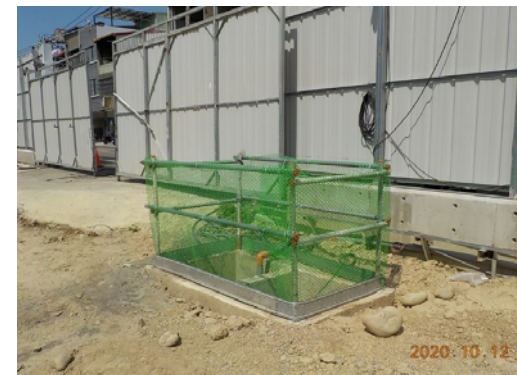
洗車台沉澱池
